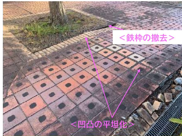
⑦くすのき台側：根上がりによる凹凸の平坦化
